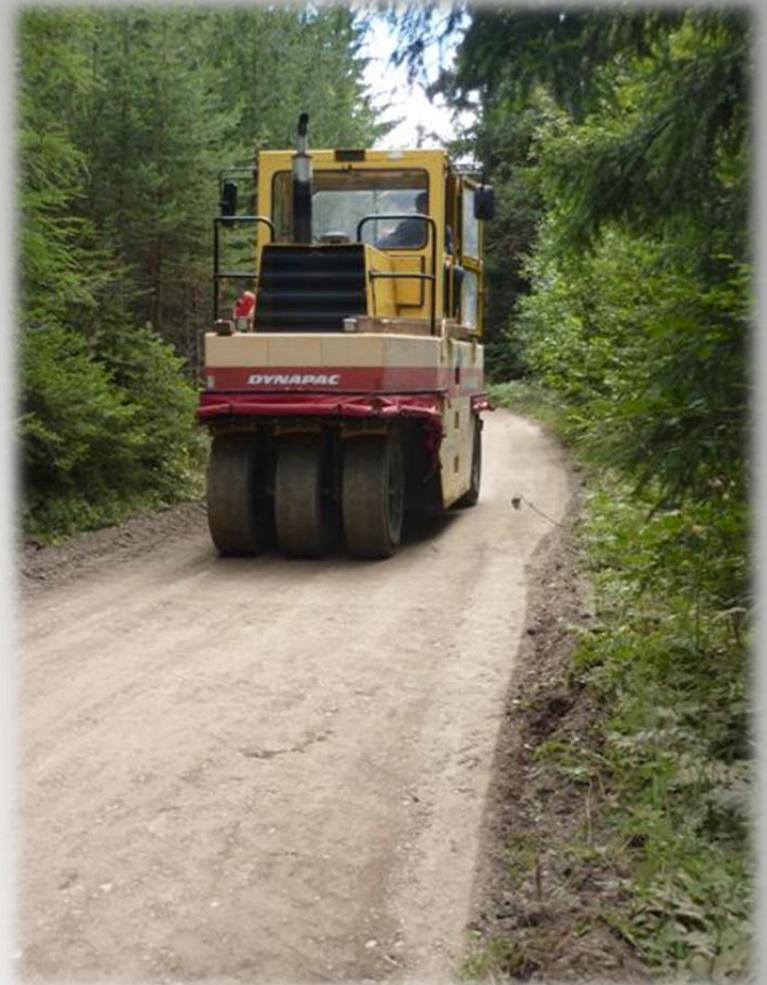
**Nachdem die Erhärungszeit des Bindemittels des Straßenuntergrunds (ca. 1 Woche) abgelaufen ist, fährt man mit dem Einbau (Kalt) einer Schicht von recycelten bituminösen Mischguts von 10 cm fort.**
