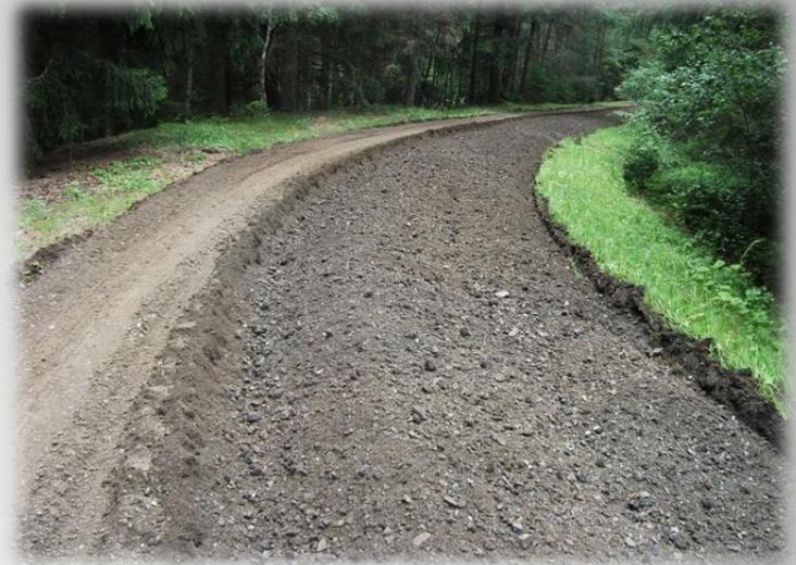
**Man fährt dann mit dem Einbau des hydraulischen Bindemittel fort, das 3% von der gesamten Mischung ausmacht. Das Material wird gemischt und homogenisiert mit einem weiteren Durchgang der Fräsmaschine.**
