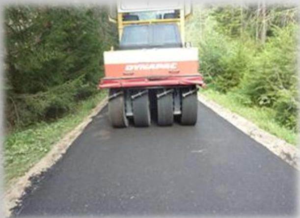
**Diese muss wiederum ausreichend zuerst mit einer Eisen-Eisenwalze und dann mit einer 20 Tonnen schweren Gummi-Gummiwalze verdichtet werden.**
