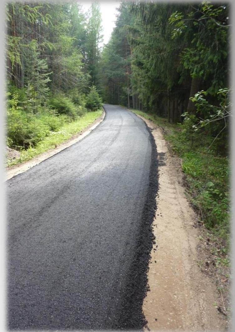
**Nach dem Auftragen einer Emulsionsschicht, fährt man schließlich mit dem Einbau einer 4 cm starken Heißasphaltschicht fort, der die Tragfähigkeit einer Binderschicht und die Abnutzung eines herkömmlichen Belags aufweist. Die ausgearbeitete Körnung für dieses Produkt beträgt 0/13 mm gebunden mit hochmodifiziertem Bitumen.**
